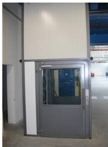
Nákladný výtah s nosnosťou 1500 kg
