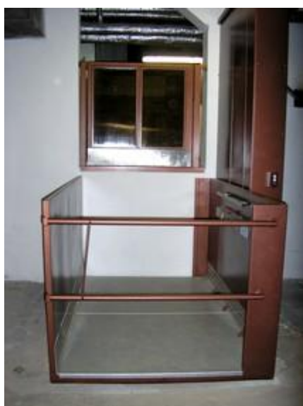
Plošina s nosnosťou 500 kg
