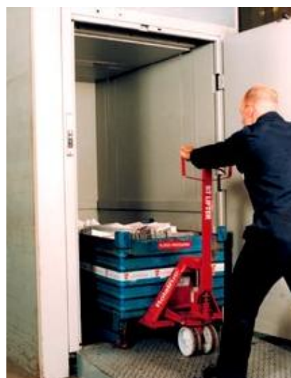
Nákladný výťah Microfreight so zaťahovacími dverami kabíny
